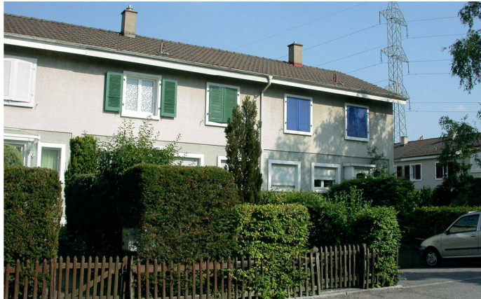
07–08 Vor und nach dem Dachausbau: Knackpunkt waren die charakteristischen Satteldächer, da sie mit einer Neigung von unter 35° eine Dachnutzung verunmöglichen würden (Unterschreitung der minimalen Raumhöhe)
