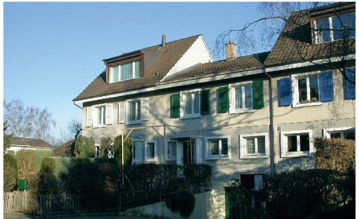
07–08 Vor und nach dem Dachausbau: Knackpunkt waren die charakteristischen Satteldächer, da sie mit einer Neigung von unter 35° eine Dachnutzung verunmöglichen würden (Unterschreitung der minimalen Raumhöhe)
