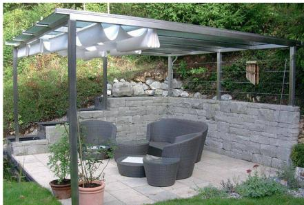
Die Creabeton Baustoff AG erweitert mit der «Landhausmauer» die Produktpalette des Santuro-Mauersystems um eine Variante. Die Landhausmauer entsteht im Prinzip der wechselnden Schichten. Die Steinhöhen variieren innerhalb der einzelnen Lagen. Blockartige Formate erzwingen Zwischenreihen, sodass die Schichten ineinander greifen und lange waagrechte Fugen verhindern. Daraus ergibt sich ein Mauergefüge, das sein Aussehen ständig verändert.
