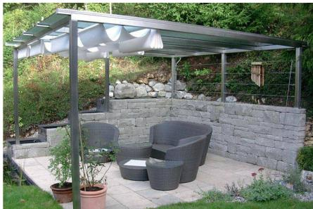
Die Creabeton Baustoff AG erweitert mit der «Landhausmauer» die Produktpalette des Santuro-Mauersystems um eine Variante. Die Landhausmauer entsteht im Prinzip der wechselnden Schichten. Die Steinhöhen variieren innerhalb der einzelnen Lagen. Blockartige Formate erzwingen Zwischenreihen, sodass die Schichten ineinander greifen und lange waagrechte Fugen verhindern. Daraus ergibt sich ein Mauergerüste, das sein Aussehen ständig verändert.
