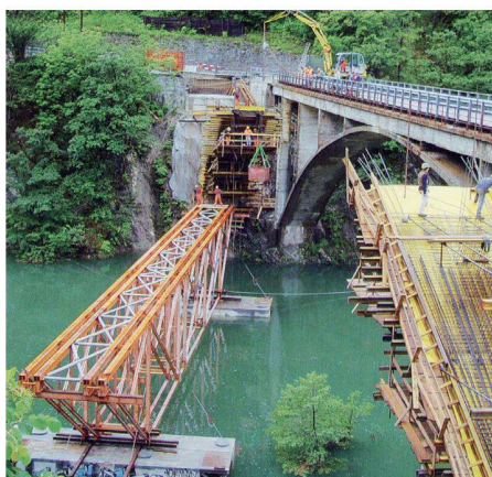
02 Das Lehrgerüst erlaubte einen Neubau neben der alten Brücke, unabhängig vom Pegelstand der gestauten Melezza (Bild: Dario Somaini, Grono)
