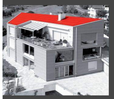
Mit nur 6° Minimalneigung ist das INTEGRAL PLAN Dachsystem kein Flachdach, aber das Flachste in seiner Kategorie. Die Plattenmodule von bis  $2500 \times 1220$  mm sorgen für das eigenständige Design.
