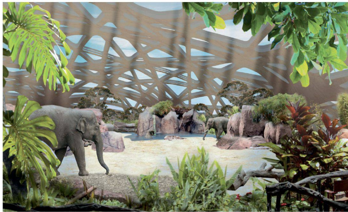
03+04 Das Hallendach von «Antoni» besteht aus einer gekrümmten, unregelmässigen Holzgitterschale, die mit transparenten Folienkissen gefüllt ist
