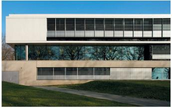
04 Maersk Mc-Kinney Moller Center, Lausanne: Der lang gestreckte, weisse Stahlbau des Lehrgebäudes mit Hörsälen und Seminarräumen ruht auf einem massiven Sockelgeschoss (Bild: Yves André, St-Aubin-Sauges)
