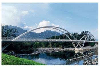
02 Doppelwelle über die Verzasca, Tenero/Gordola: Eine alte Steinbrücke über die Verzasca gab die Form für die 120 m lange Stahlbrücke aus zwei gebogenen Rundrohren (Bild: Danny Noel, Agarone)
