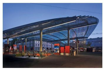
01 Welle, Bern: viel diskutierte Stahlkonstruktion aus sechs Kastenträgern auf zwölf eingespannten Stahlstützen und quer verlaufenden, zweifach gekrümmten Sekundärträgern (Bild: Tuchschmid / Alexander Gempeler, Bern)
