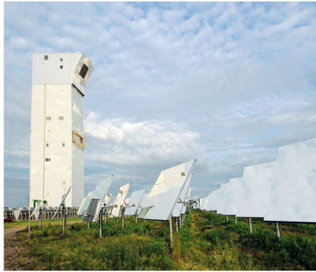
01+02 Solarturmkraftwerk: 60m hoher Turm mit Receiver und Heliostatfeld mit über 2000 Spezialspiegeln (Fotos: Deutsches Zentrum für Luft- und Raumfahrt, DLR)
