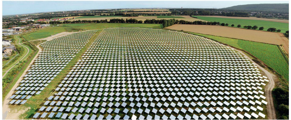
01+02 Solarturmkraftwerk: 60m hoher Turm mit Receiver und Heliostatfeld mit über 2000 Spezialspiegeln (Fotos: Deutsches Zentrum für Luft- und Raumfahrt, DLR)
