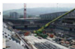
Bild 1: Versetzen der Elemente mit Autokran
