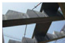
Bild 3: Tribünentragkonstruktion: Die Sägezahnträger
