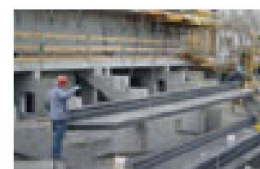
Bild 4: Versetzen der Elemente durch die BRUN-eigene Montageequipe
