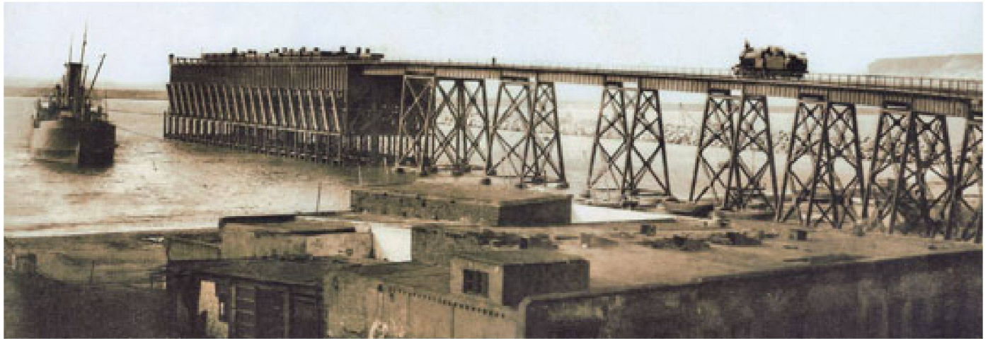
01 Verladestation für mineralische Rohprodukte im Hafen von Almeria (E), mit Transportschiff und dampfgetriebener Transportbahn, um 1905 (Originalfoto: Andrés Fabart, Colección arráez de fotografías antiguas)
