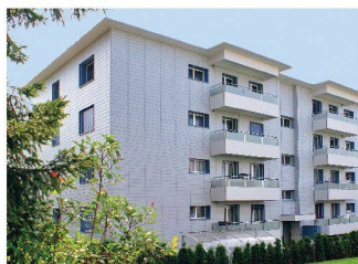
Die hinterlüftete Fassade mit Faserzementplatten sorgt für höchste Energieeffizienz.
