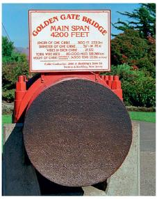
02 Stahlkabel der Golden Gate Bridge mit einem Durchmesser von 92 cm, bestehend aus üher 27000 Finzeldrähten
