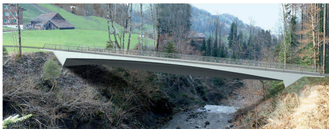
06 «Duett»: Suggestiert ein Kräftespiel – Spannbetonbrücke mit zwei untenliegenden geschwungenen Längsträgern
