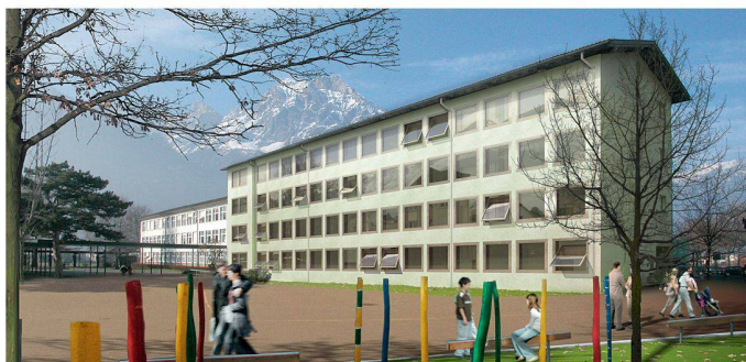
01+02 «Foulard»: Das Spiel der neuen Kippfenster belebt die sanierte Südfassade, im Norden wird die Wärmedämmung verstärkt (Bilder: Verfassende)
