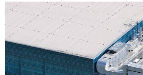
Die gesamte Dachfläche der Eishalle von 3900 m<sup>2</sup> (Bild oben) wurde als Nacktdach mit SUCOFLEX-CM ausgeführt. Mit einem mechanisch befestigten Dachsystem lässt sich das Flächengewicht der Dachkonstruktion auf ein Minimum reduzieren. Die anderen Dachflächen von 2400 m<sup>2</sup> (Bild unten) wurden mit SUCOFLEX-CB ausgeführt und anschliessend bekiest.
