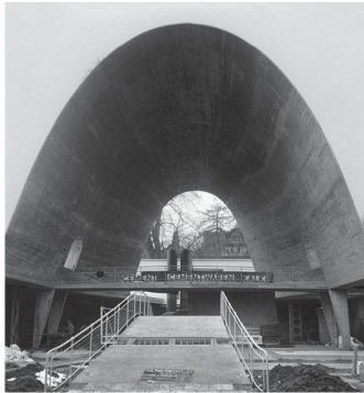
Pavillon der Schweizer Zementindustrie an der Landesausstellung 1939 in Zürich. Bewehrte Spritzbetonschale, an zwei Bogenrippen aufgehängt. Spannweite 16 m, Höhe 15 m, Länge 21.4 m, Wand- stärke 6 cm. Ingenieur: Robert Maillart; Architekt: Hans Leuzinger (Bild: KEYSTONE/PHOTOPRESS- ARCHIV/Str)
