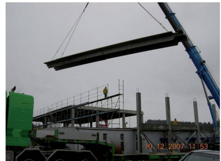
Montage der Rippenplatten direkt ab LKW
