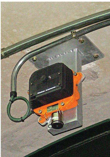
Einer der längsten Eisenbahntunnel der Welt wird mit Gaswarngeräten der Firma Crowcon Detection Instruments vor gefährlichen Gas-Konzentrationen geschützt. Die Crowcon-Systeme sind so ausgelegt, dass sie leicht entzündliche und giftige Gase aufspüren, bevor diese gefährliche Konzentrationen erreichen.
