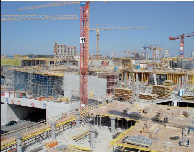
ca. 1'500 Betonstützen teilweise mit Betonpilzen
