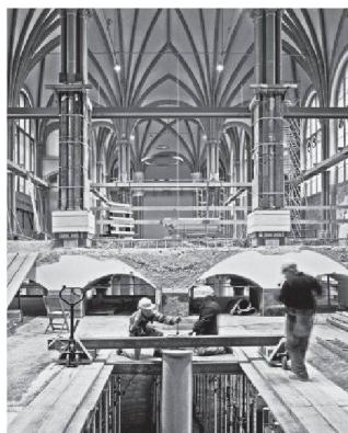
Blick in die Ruhmeshalle, den zentralen Raum im Obergeschoss des Bahnhofflügels. Der Boden – zugleich auch die Decke der darunterliegenden Säulenhalle – wurde neu betoniert; damit der denkmalgeschützte Terrazzoboden im Sockelgeschoss nicht durch herabfallende Teile des Abbruchs beschädigt wird, ist eine Holzplattform errichtet worden
