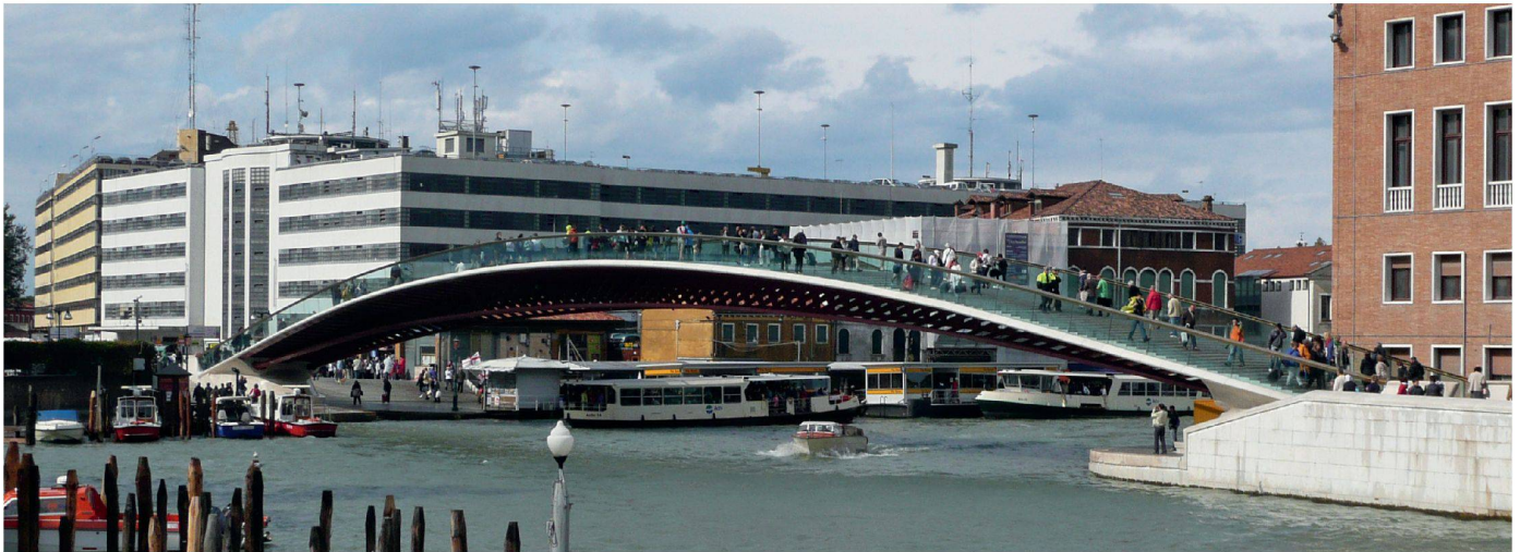
01 Blick über den Kanal Richtung Piazzale di Roma (Fotos: js/Red.)
