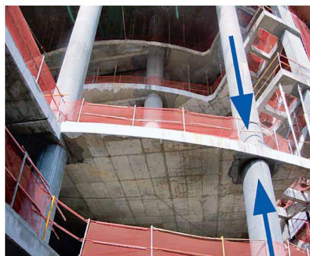
09 Roberto Guidotti, «Etude du comportement structural des joints colonnes – dalle dans les planchers dalle en béton armé»: Der Diplomand führte seine Forschungsarbeit bezüglich Spannungs- und Dehnungsverhalten am Detail Stützenfuss-Decke-Stützenkopf aus (Bild: Roberto Guidotti)
