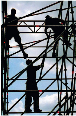
Arbeiter montieren ein Baustellengerüst. Wie bei der Ausführung sind auch bei der Planung von Bauvorhaben eine eingespielte Zusammenarbeit und eine gute Umgangskultur, die diese ermöglicht, notwendige Voraussetzungen (Bild: KEYSTONE/CARO/Claudia Hechtenberg)
