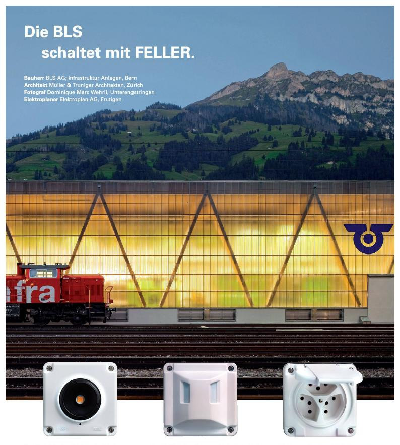
Der Betrieb des Alptransit-Basistunnels durch den Lötschberg machte die Erstellung des neuen Werkhofes der BLS in Frutigen nötig. Die mehrfach preisgekrönten Hallen, deren Tragstruktur aus Holz gefertigt und mit grüngrau eingefärbten Stegplatten aus Polycarbonat verkleidet sind, lassen den Baukörper je nach Wetter- und Lichtstimmung massiv, metallen, gläsern oder transparent erscheinen. Der Nutzung des Gebäudes angepasst findet das robuste Nass-Sortiment Verwendung. Die BLS schaltet mit FELLER.
