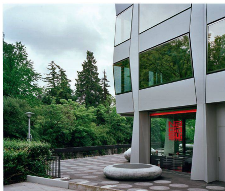
04 Die Belüftung der Tiefgarage ist ebenfalls in einem Betonelement untergebracht (Bild: Georg Aerni)
