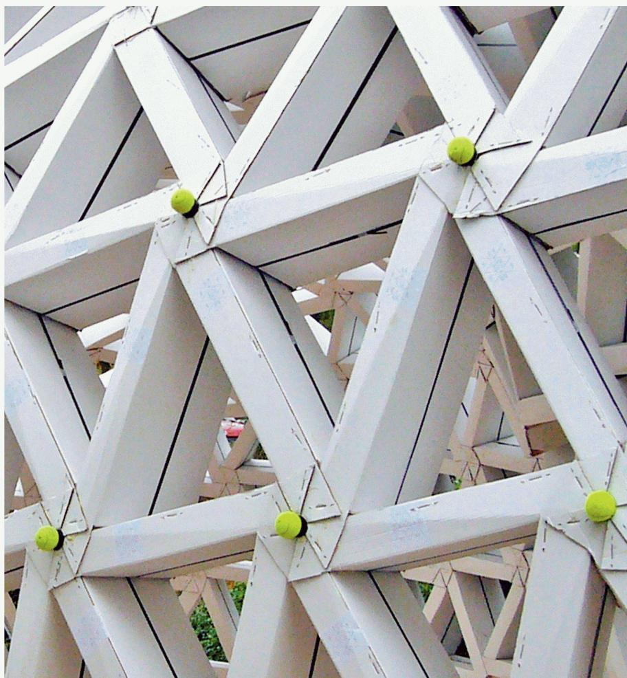
03-05 Die Hüllform wurde mithilfe einer 3-D-Software entwickelt, anschliessend konnte ein Konzept für die angestrebte, auf Dreiecken basierende Tragstruktur entwickelt werden. Die farbigen Dreiecke und die Schnittmuster mit sämtlichen Laschen sind nicht gezeichnet, sondern Produkt eines hierfür programmierten Computer/CAD-Skripts
