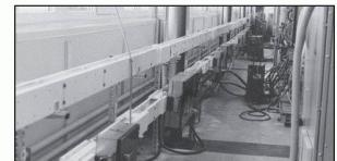
**LANZ HE-Stromschienen zur sicheren Stromübertragung und -Verteilung IP 68 § Giessharzvergossen 400 A – 6000 A**
