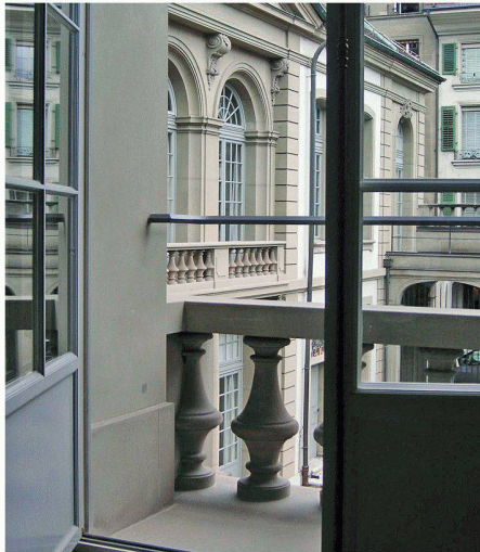
02 Balustrade vor einem wenig tiefen Balkon mit Fenstertüren in einem Gebäude um 1755, heute genutzt als Verwaltungsgebäude. Ein zusätzlicher Wehrstab in Normhöhe schützt vor unbeaufsichtigtem Überkippen. Die zu breiten Öffnungen zwischen den Balustern und die zu grosse Lücke zwischen Balustradenabdeckung und Wehrstab werden akzeptiert
