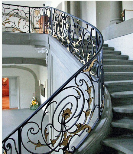
03 Historisches Geländer im gleichen Gebäude. Das Geländer wurde trotz zu geringer Höhe und zu grossen Öffnungen ohne Veränderungen beibehalten
