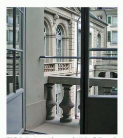
02 Balustrade vor einem wenig tiefen Balkon mit Fenstertüren in einem Gebäude um 1755, heute genutzt als Verwaltungsgebäude. Ein zusätzlicher Wehrstab in Normhöhe schützt vor unbeabsichtigtem Überkippen. Die zu breiten Öffnungen zwischen den Balustern und die zu grosse Lücke zwischen Balustradenabdeckung und Wehrstab werden akzeptiert
