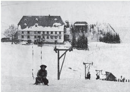
01 Der erste patentierte Skilift der Welt funktionierte mit Wasserkraft (Bild: www.eisenbach.de)
