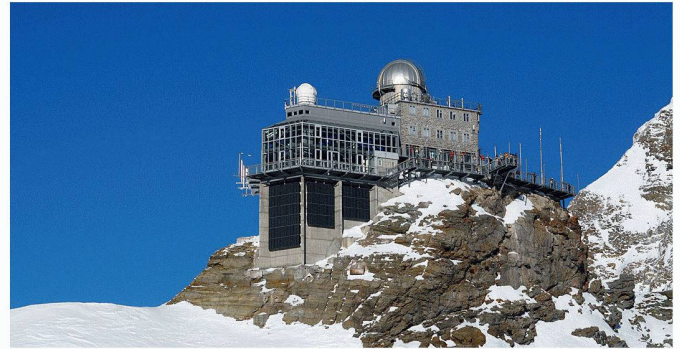
01+02 Solarkraftwerk auf dem Jungfraujoch: Die Solarpanels wurden an drei Fassadenflächen an der «Sphinx» angebracht. Zwei Flächen sind exakt gegen Süden ausgerichtet, eine gegen Südwesten (Bild: BKW)
