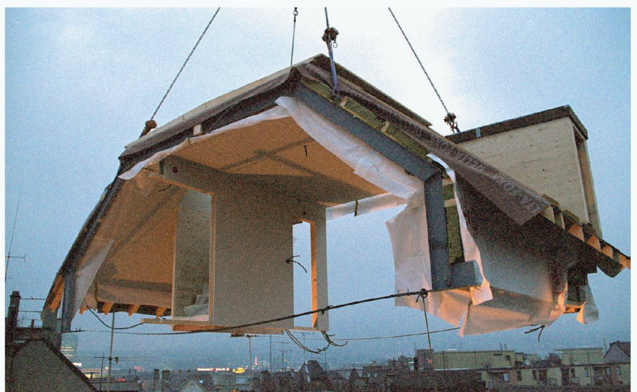
01 Die Forschung arbeitet unter anderem an Lösungen, um die energetische Sanierung von Altbauten zu erleichtern. Eine Variante sind vorgefertigte Dachmodule, in die Anlagen zur Nutzung von Sonnenenergie und die Komfortlüftung bereits integriert sind, wie sie bei der Sanierung eines Gebäudes an der Magnusstrasse in Zürich eingesetzt wurden (Bild: K. Viridén, Zürich)
