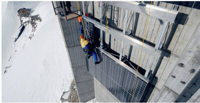
01+02 Solarkraftwerk auf dem Jungfraujoch: Die Solarpanels wurden an drei Fassadenflächen an der «Sphinx» angebracht. Zwei Flächen sind exakt gegen Süden ausgerichtet, eine gegen Südwesten (Bild: BKW)
