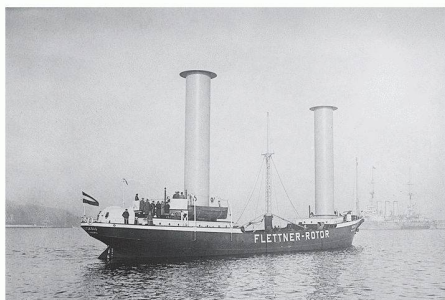
02 MS «Buckau» mit Flettnerrotoren, 1924 (Bild: George Grantham Bain Collection)
