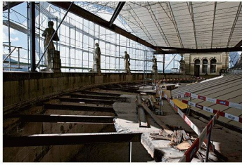
Sanierung des Bundeshauses, Bern, August 2006 (Bild: KEYSTONE / Alessandro della Valle)
