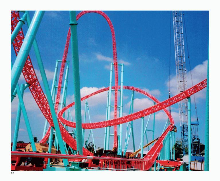
werden die Kurvenübergänge, ähnlich wie im Strassenbau, als Klothoiden ausgeführt, sodass der Radius bei der Ein- und der Ausfahrt deutlich grösser ist. Eine Querneigung der Schiene hat zudem zum Ziel, die hohen Fliehkräfte bei einer Kurvenfahrt in eine Vertikalkraft zu verwandeln, sodass der Fahrgast in den Sitz gedrückt wird. Diese Elemente führen dazu, dass Kurven auch mit hoher Geschwindigkeit relativ sanft durchfahren werden.
