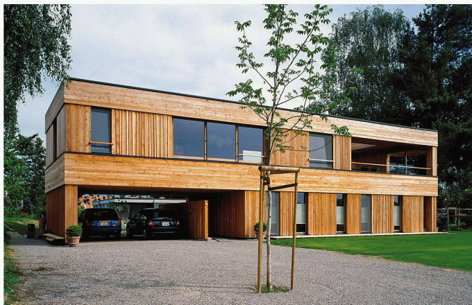
01 Unregelmässig strukturierte Fassaden aus gehobelten und sägerauen Lärchenholzplatten umhüllen die Holzrahmenkonstruktion
