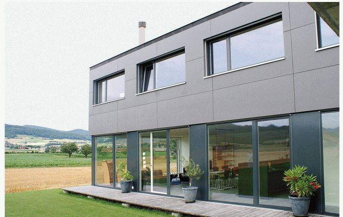
02 Wand- und Deckenkonstruktion bestehen aus Holz, den Charakter des Hauses prägen dunkelgraue Fassaden- und weisse Gipskartonplatten (Hauptpreisträger: «Wohnhaus in Obergösgen», H & O Oegerli Brunner, Olten)
