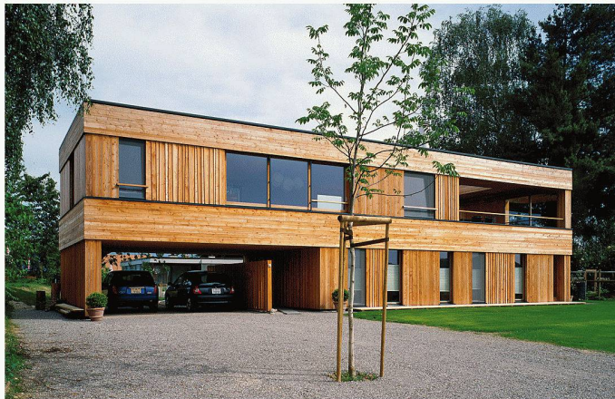
01 Unregelmässig strukturierte Fassaden aus gehobelten und sägerauen Lärchenholzplatten umhüllen die Holzrahmenkonstruktion (Hauptpreisträger: «Wohnhaus in Hessigkofen», Dual Architekten, Solothurn)
