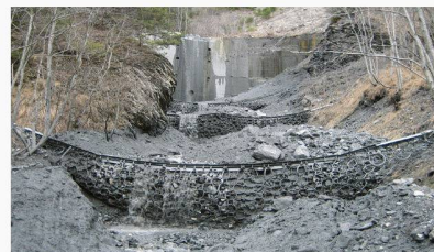
Die ausgebildeten Stufen der drei natürlich verfüllten Barrieren nach dem zweiten Murgang
