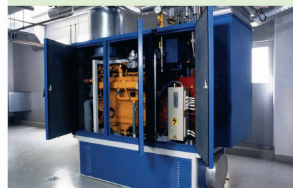
Gasmotor-Blockheizkraftwerk (BHKW)
