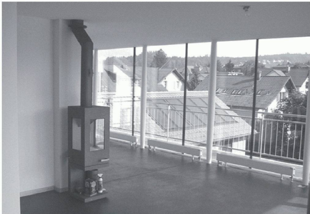
MFH Scheuermann: Etagenofen für die Übergangszeit Solarkollektoren für das Warmwasser
