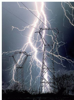
Höchstspannungen: Übertragungsleitungen (380 kV, Stromstärken um 1000 A) und Blitze (einige Millionen V, Stromstärken um 20000 A) (Bild: KEYSTONE / SUNSET / Didier Pivx)
