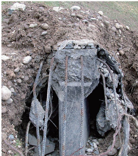
01 Die eingestürzte Decke in Gretzenbach (Bild: Aurelio Muttoni, ETH Lausanne)
