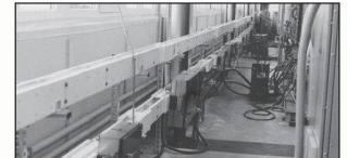
**LANZ HE-Stromschienen zur sicheren Stromübertragung und -Verteilung IP 68 § Giessharzvergossen 400 A – 6000 A**
