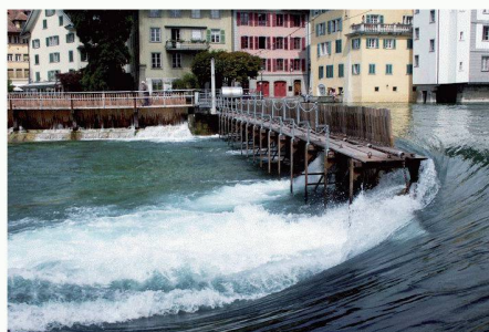
02–04 Stirnwehr, die so genannte Welle und Arbeiten am Steg. Zur Öffnung des Wehrs werden die Nadeln gezogen. Anschliessend werden die Bretter des Stegs entfernt, und die Metallböcke lassen sich auf Grund herunterklappen. Eine der Befürchtungen der Projektgegner ist, dass die Welle verschwinden würde (Bilder: Autor)
