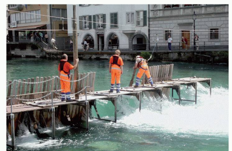
02–04 Stirnwehr, die so genannte Welle und Arbeiten am Steg. Zur Öffnung des Wehrs werden die Nadeln gezogen. Anschliessend werden die Bretter des Stegs entfernt, und die Metallböcke lassen sich auf Grund herunterklappen. Eine der Befürchtungen der Projektgegner ist, dass die Welle verschwinden würde (Bilder: Autor)
