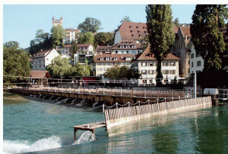
02–04 Stirnwehr, die so genannte Welle und Arbeiten am Steg. Zur Öffnung des Wehrs werden die Nadeln gezogen. Anschliessend werden die Bretter des Stegs entfernt, und die Metallböcke lassen sich auf Grund herunterklappen. Eine der Befürchtungen der Projektgegner ist, dass die Welle verschwinden würde (Bilder: Autor)
