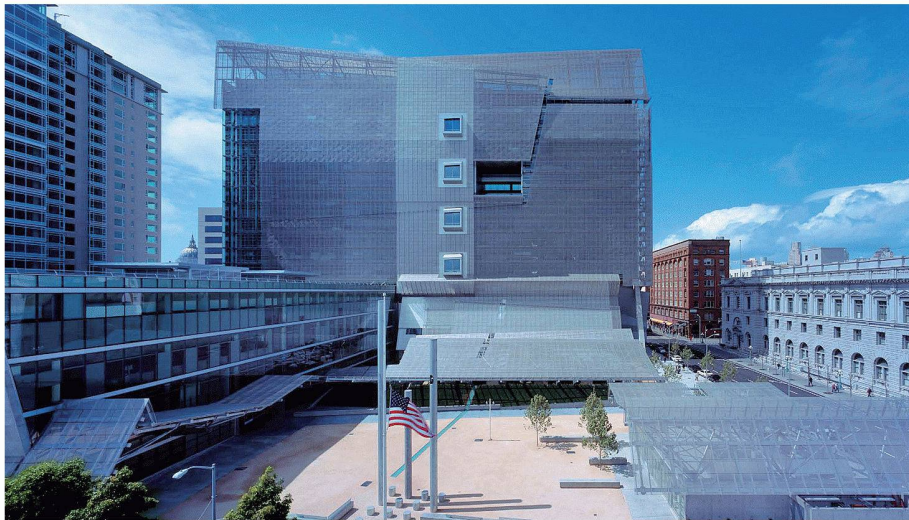
01 Das «Federal Building» wird weitgehend natürlich belüftet und belichtet und spart so viel Energie (Morphosis, Santa Monica, USA)
