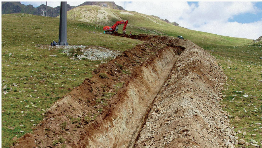
01 Werden die Umwelanliegen bereits in einer frühen Phase des Bauprojektes einbezogen, erleichtert das die Umsetzung. Im Bild: Erstellung einer Beschneigungsleitung in Suvretta/St. Moritz (Bild: N. Locher)
