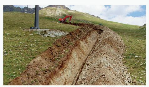
01 Werden die Umweltanliegen bereits in einer frühen Phase des Bauprojektes einbezogen, erleichtert das die Umsetzung. Im Bild: Erstellung einer Beschneiungsleitung in Suvretta/St. Moritz (Bild: N. Locher)
