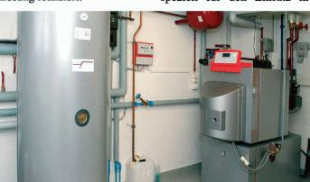
Eine effiziente Wärmeerzeugung ist mit einem modernen Ölheizkessel garantiert.
