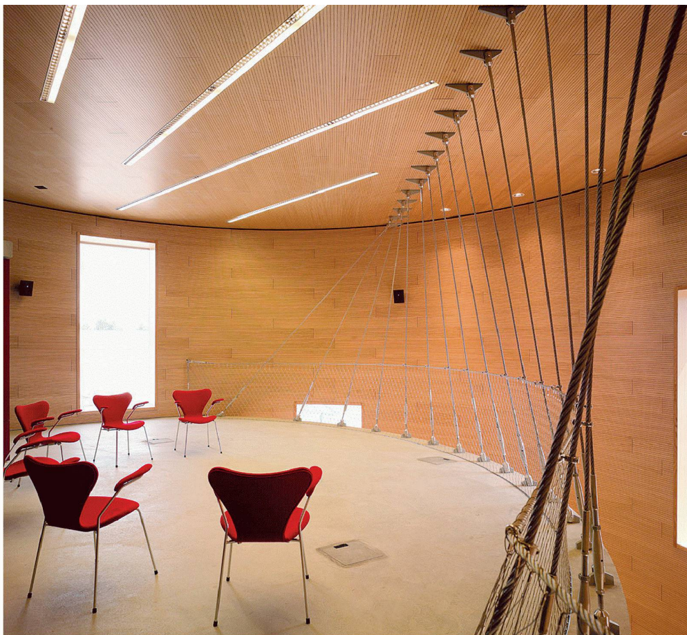
18–20 Das vom «Fass des Diogenes» inspirierte Innenleben des ehemaligen Tanks mit dem an Stahlseilen aufgehängten Betonboden (Bilder: Wehrli Müller Fotografien)
