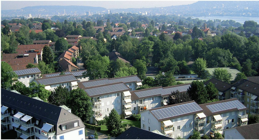
01 Strom von den Dächern einer Zürcher Baugenossenschaft (Bild: ch-fo / Edisun Power AG)
