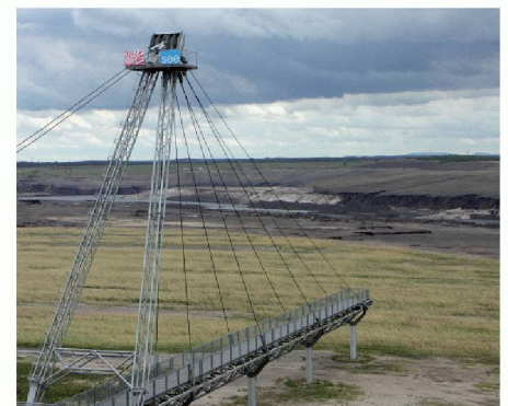
Warten auf das Wasser: In etwa elf Jahren sollen die Pfeiler des Steges im Ilse-See stehen.
