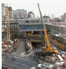
02 Terminlich exakt abgestimmter Geleisebau nach dem Fertigstellen des Trassees mit Weiterführung des Betonbaus der Stationen. Station Flon, Stand März 2007 (Bild: Métro Lausanne-Ouchy SA)
