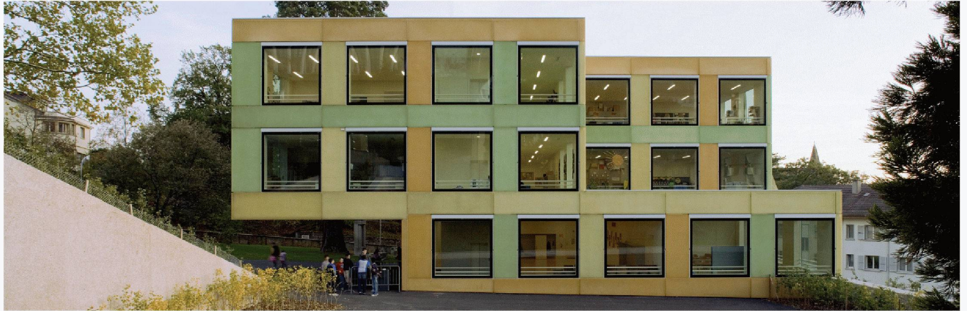
Prämiertes Schulhaus in Neuenburg von Andrea Bassi, Architekt, und Guscetti & Tournier, Ingenieure: Das Erdgeschoss und die Obergeschosse sind als Stahlverbundkonstruktion mit Glas- und Leichtfassade ausgebildet (Bilder: Guscetti & Tournier)
