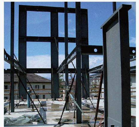
Die Erdbebenkräfte der Zone 1 erfordern ein massives Stahltragwerk
