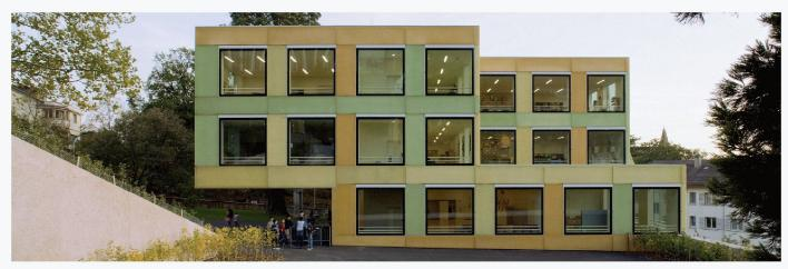
Prämiertes Schulhaus in Neuenburg von Andrea Bassi, Architekt, und Guscetti & Tournier, Ingenieure: Das Erdgeschoss und die Obergeschosse sind als Stahlverbundkonstruktion mit Glas- und Leichtfassade ausgebildet (Bilder: Guscetti & Tournier)
