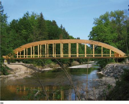
02 Die neue Hauptbrücke über die Emme wurde vormontiert und per Kran auf die vorbereiteten Fundamente gesetzt
