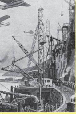
02 Durch die Absenkung des Mittelmeerspiegels um 200 m enstanden grosse Flächen Neuland, die im Bild schwarz dargestellt sind. 1) Staudamm Gibraltar, 2) Tunis-Dämme, 3) Wassersammelbecken Choot el Djerid, 4) Gallipoli-Kraftwerke (Bild: Sörgel 1929, S. 29) 03 + 05 Schnitt durch den 100 m hohen und 1.6 km breiten Gibraltardamm und Zeichnung Baustelle (Bild: Sörgel 1932, S. 13 und S. 18)
